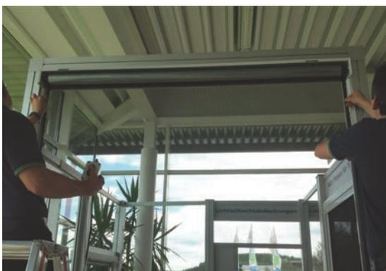
Dabei muß das Gewebe oben rechts und links von Hand geführt werden, so dass sich dieses gerade aufwickelt (Spiralen liegen übereinander).
