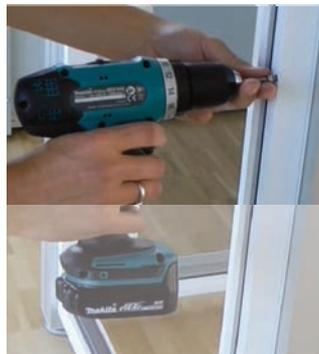
Kastenblende wieder einhängen, einklipsen und anschrauben.
