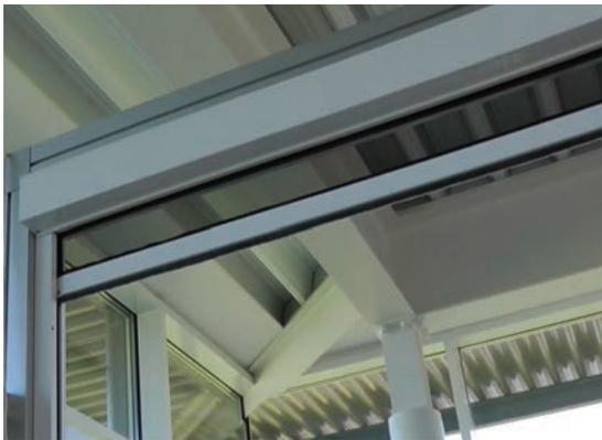
Abdeckprofile der seitlichen Führungsschienen abschrauben.
