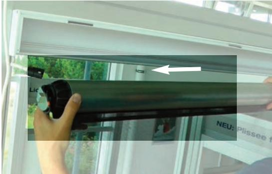
Altes Gewebe aus der Nut ziehen und entsorgen. Stahlwelle, wenn möglich vor dem Elektro-Rollo-Element, mit Nut nach oben ausgerichtet, auf den Boden legen.
