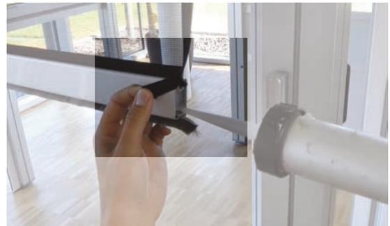
**17** Zuerst hinten die Führungsteile einführen (neue verwenden). Nach unten überstehenden Reißverschluss (30mm) darüber legen.
