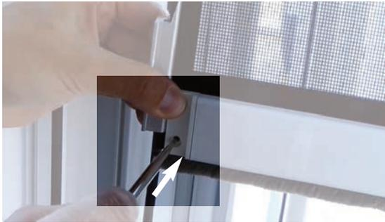
Spirale parallel zum Führungsteil verschrauben. Anschließend Gewebespannlehre nach unten rausziehen.
