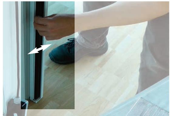
**22** Abdeckprofile rechts und links wieder einsetzen und anschrauben.
